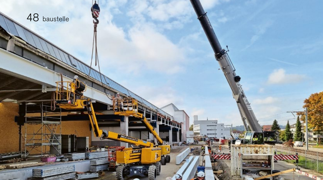
Die neue Fassade für die Rampenhalle entsteht.
