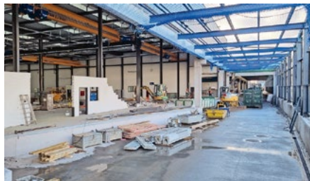
Die überdeckten Ladekanten für die Lastwagen nehmen Gestalt an.
